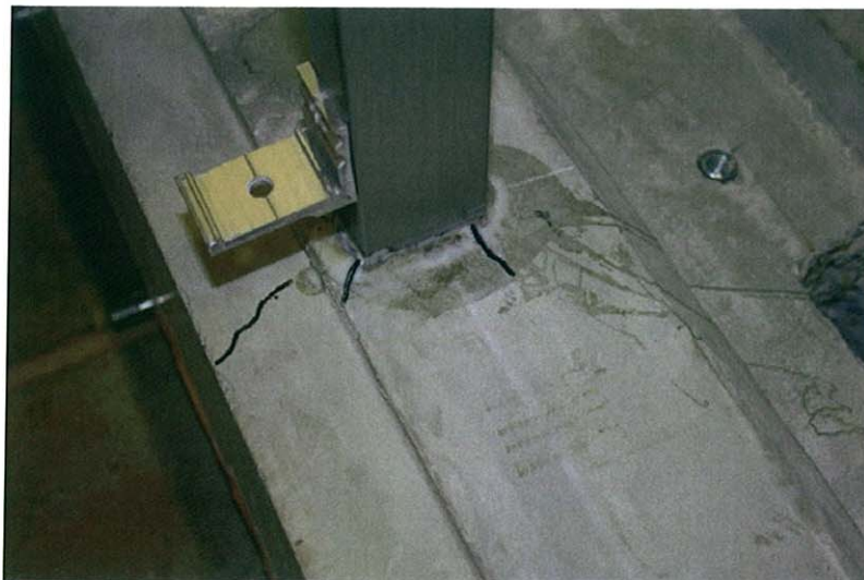
写真-4・1・6 破壊状況 ユニットの水平荷重試験 支持脚部の破壊状況 (試験体:UK-B)
