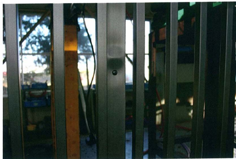
写真-4.1.3 破壊状況 ユニットの水平荷重試験 中央補強材頂部の破壊状況 (試験体:UK-A)
