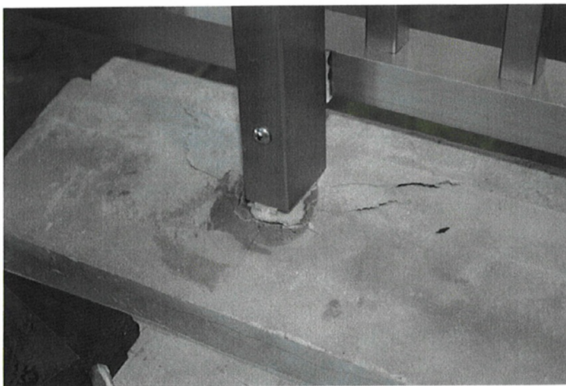
写真-4・1・3 破壊状況 ユニットの水平荷重試験 (中央部支柱の破壊状況)150型
